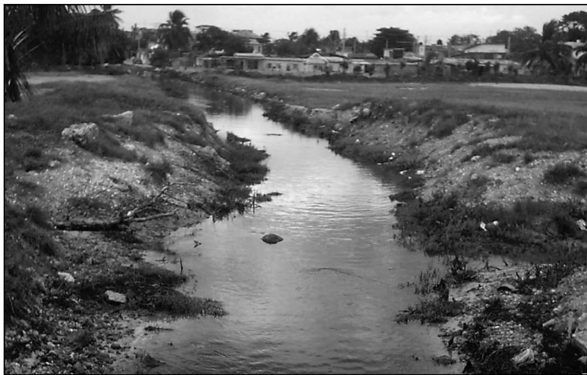
ZANJA de aguas residuales que vierten hacia el mar.
